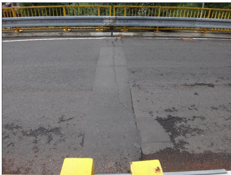
MZ ve vozovkové části nad podpěrou 1
