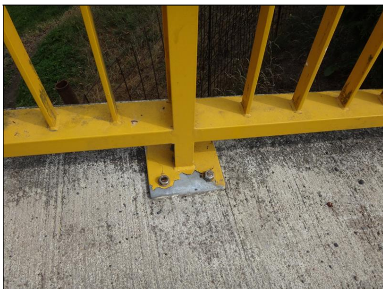
Poruchy PKO zábradlí
