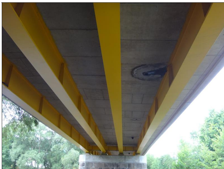
Zatékání na podhled NK v prostoru odvodňovacích trubiček v poli 1
