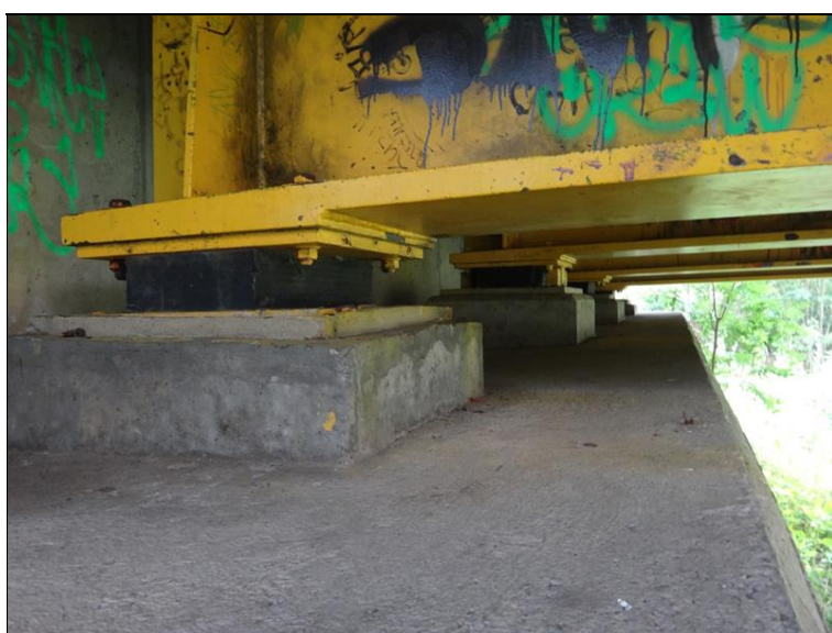
Detail uložení na podpěře 4
