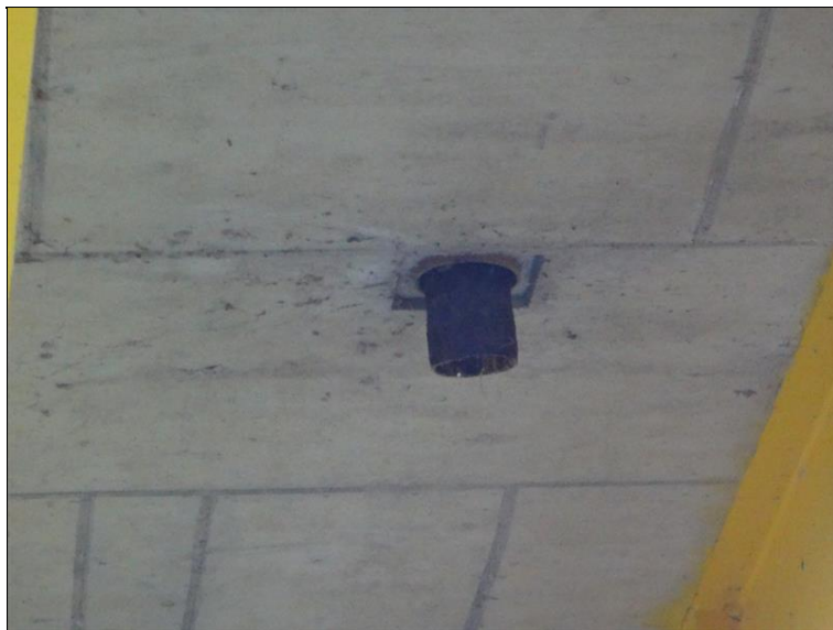
Detail vyústění mostních odvodňovačů
