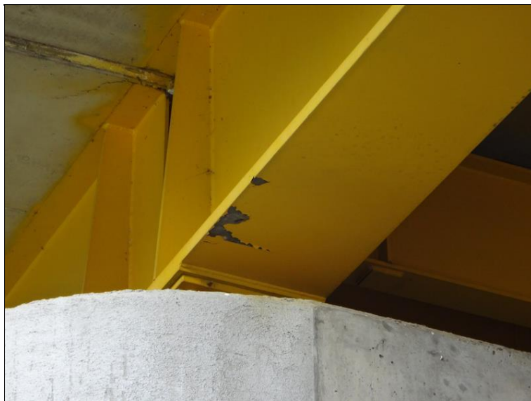
Poruchy PKO NK v prostoru podpěry 3
