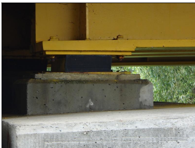
Detail uložení na podpěře 1
