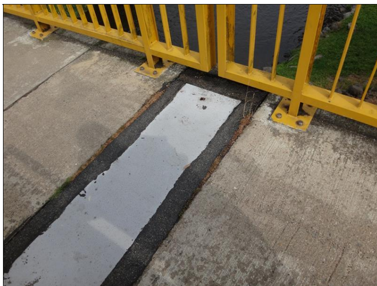
Detail MZ na opěře 1 vpravo
